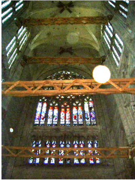
临时措施防止博韦大教堂倒塌。
